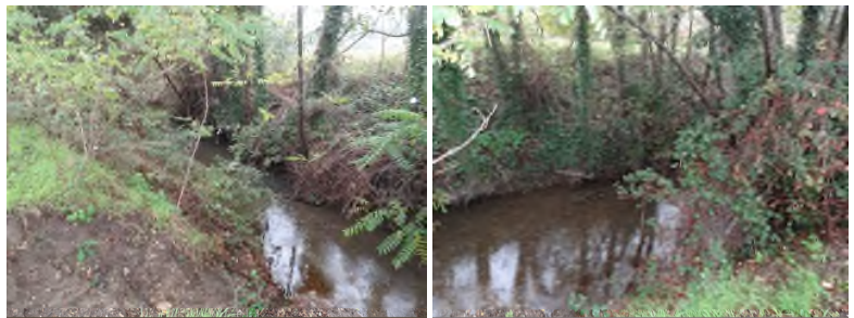
Photo – Vues du canal affecté par la traversée du réseau d'adduction
