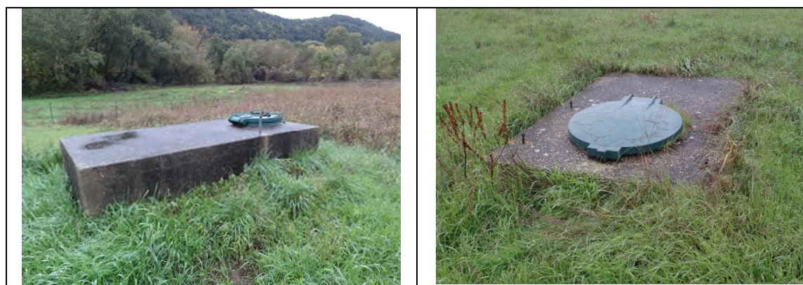
Cuvelage du forage F1
